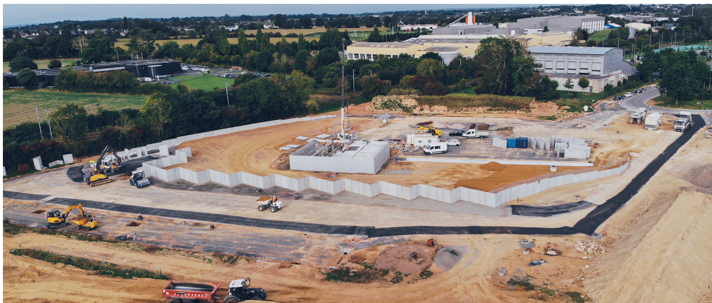
Nouvelle déchèterie de Bayeux - Avancement des travaux
