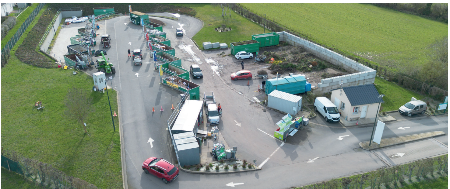
Déchèterie de Vaucelles
