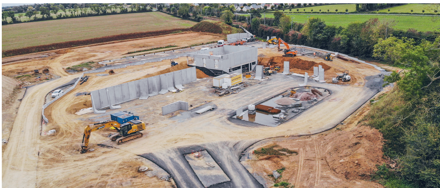
Nouvelle déchèterie de Bayeux - Avancement des travaux
