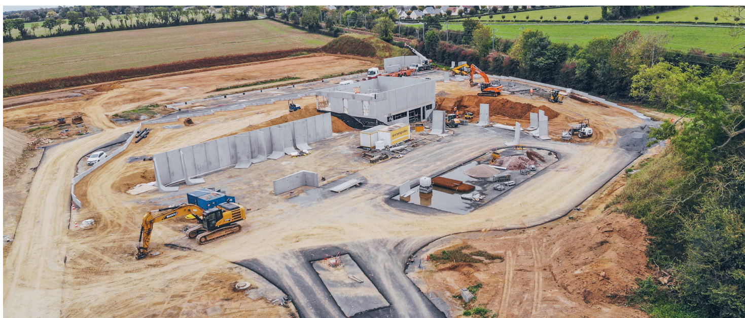
Nouvelle déchèterie de Bayeux - Avancement des travaux
