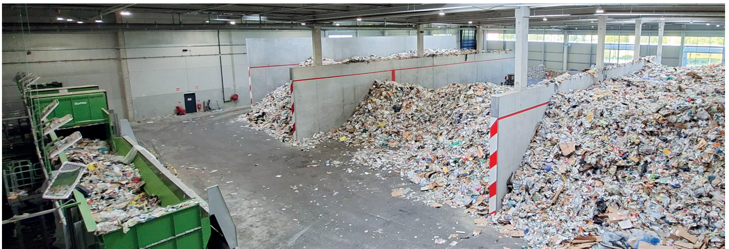
Normantri : zone de réception des déchets
