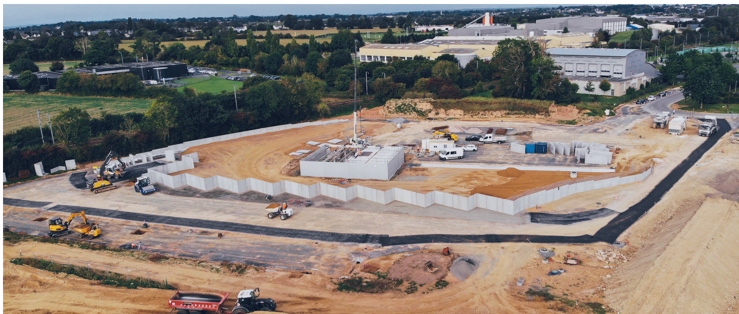
Nouvelle déchèterie de Bayeux - Avancement des travaux
