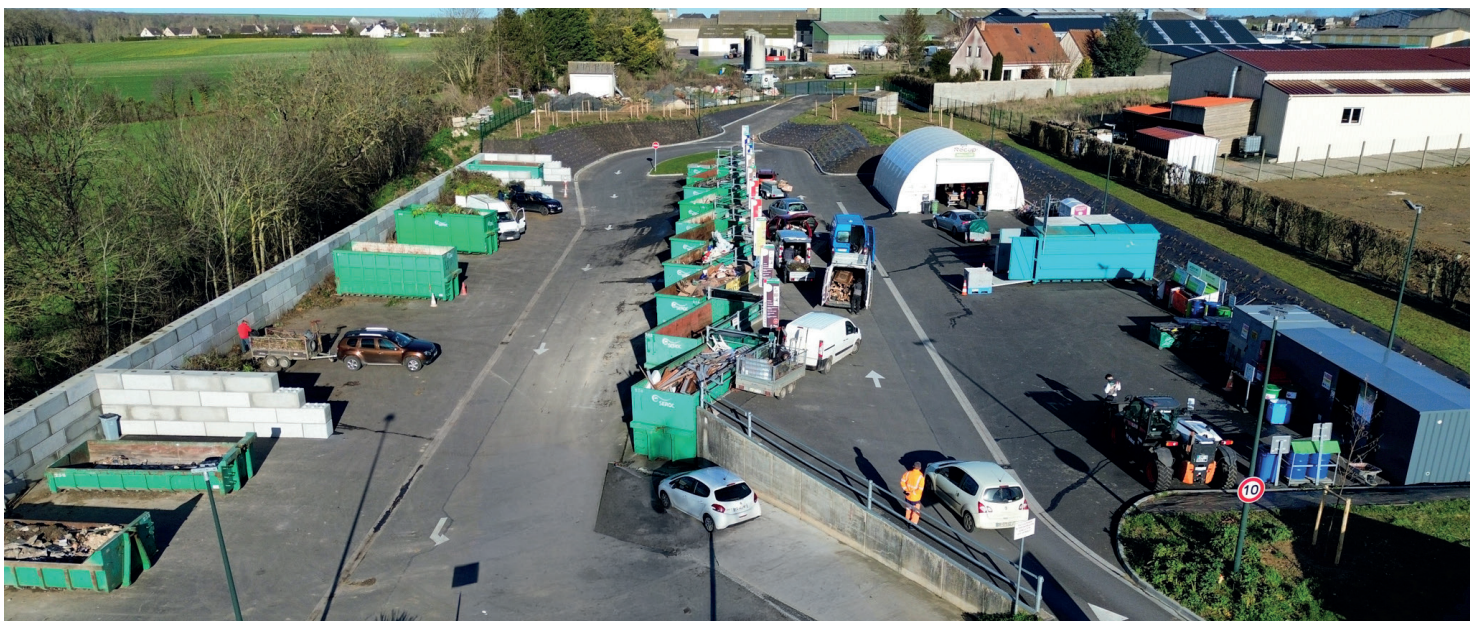
Déchèterie de Creully après travaux
