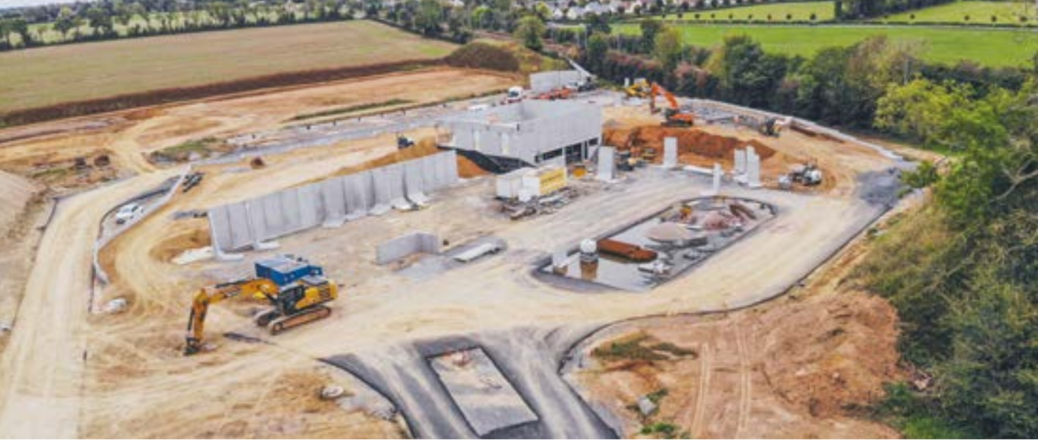
Nouvelle déchèterie de Bayeux - Avancement des travaux
