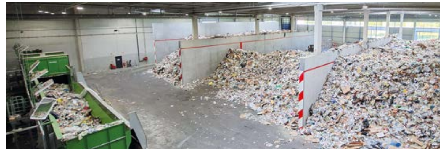
Normantri : zone de réception des déchets
