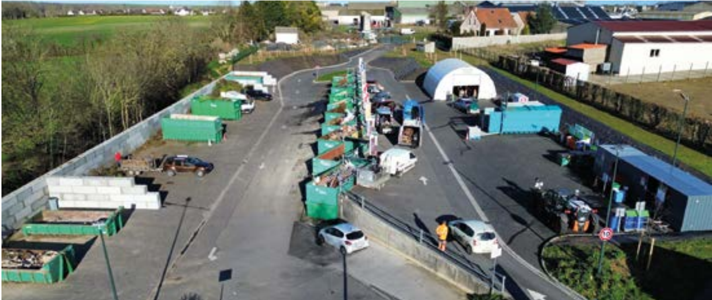
Déchèterie de Creully après travaux
