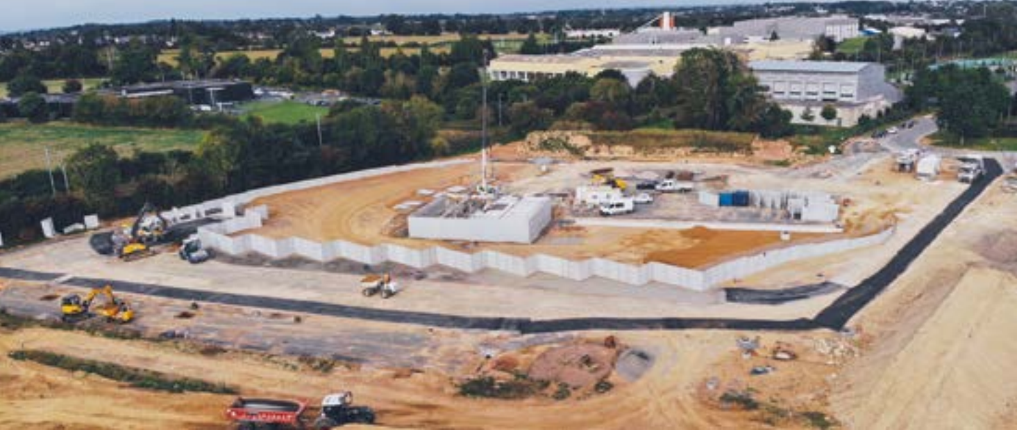
Nouvelle déchèterie de Bayeux - Avancement des travaux
