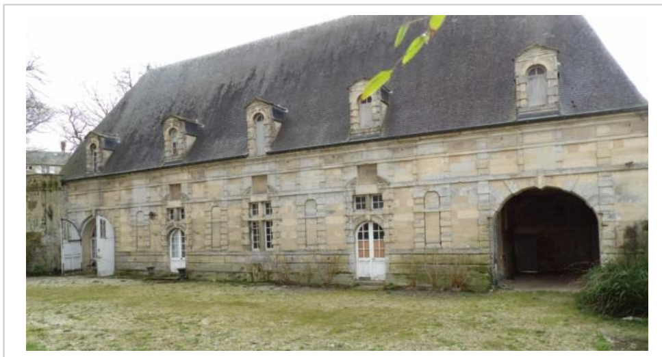
La première tranche des travaux de réhabilitation du château de Creully pourrait concerner les écuries. © Ouest-France
